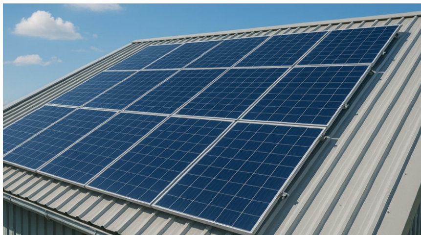
Figura 3. Imagem ilustrativa de painéis instalados em telhado existente
