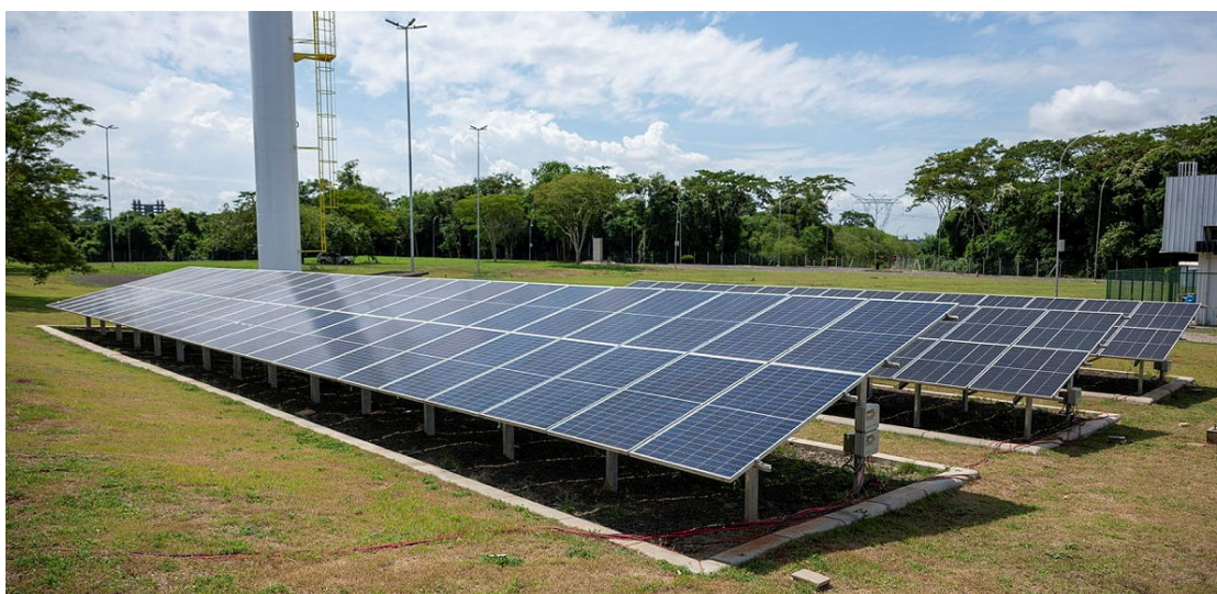
Figura 2. Foto de instalação de painéis em solo
