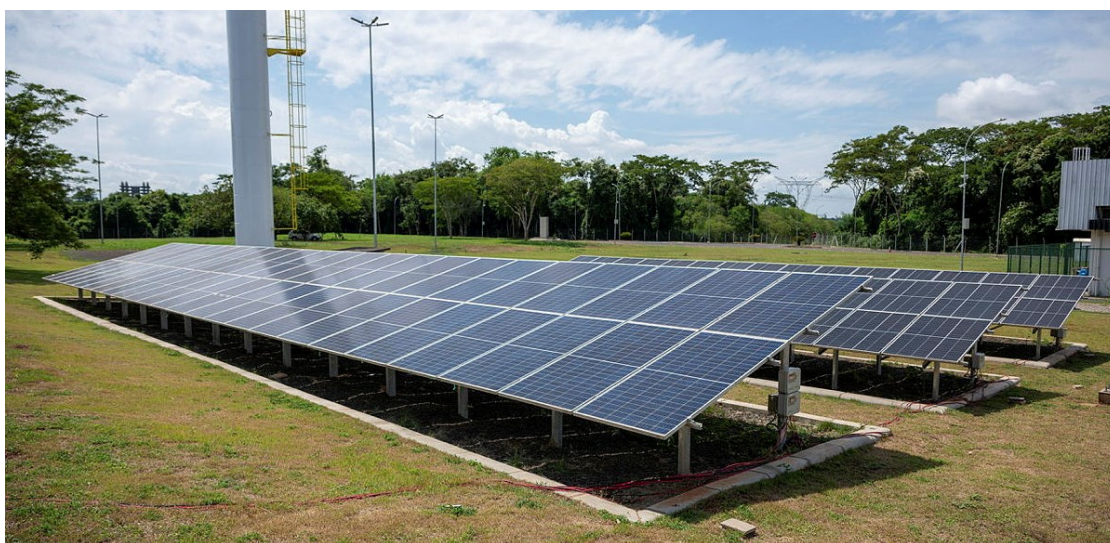
Figura 2. Foto de instalação de painéis em solo
