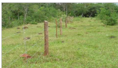
Construção de Cerca Tipo 1 em Mercedes-PR para o isolamento de Mata Ciliar
