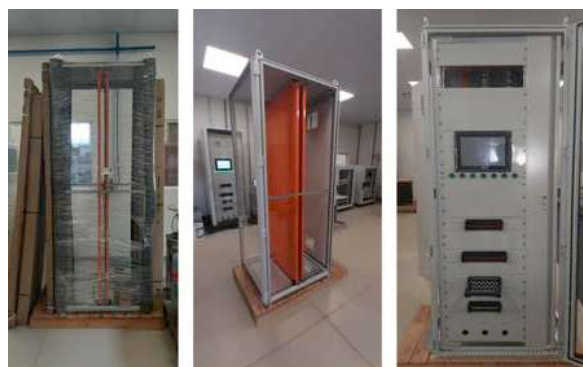
Montagem dos novos painéis.
