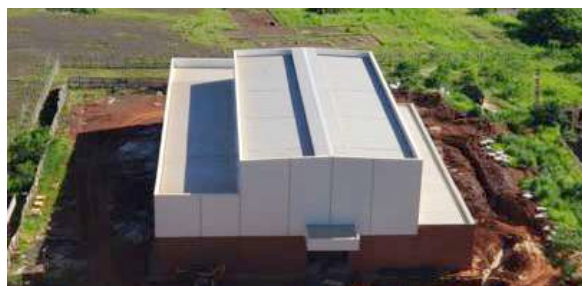
Unidade de proteção anticorrosiva e carpintaria.
