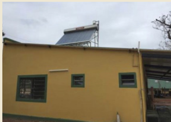
Sistema híbrido de geração (SGH) de energia elétrica.
