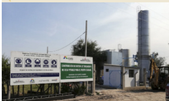
◀ Estação de Tratamento - Sapucaí.
