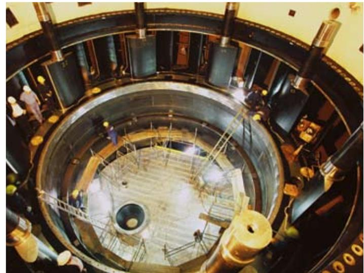
O rotor é um dos componentes de uma unidade geradora e pesa 1.760 toneladas.
