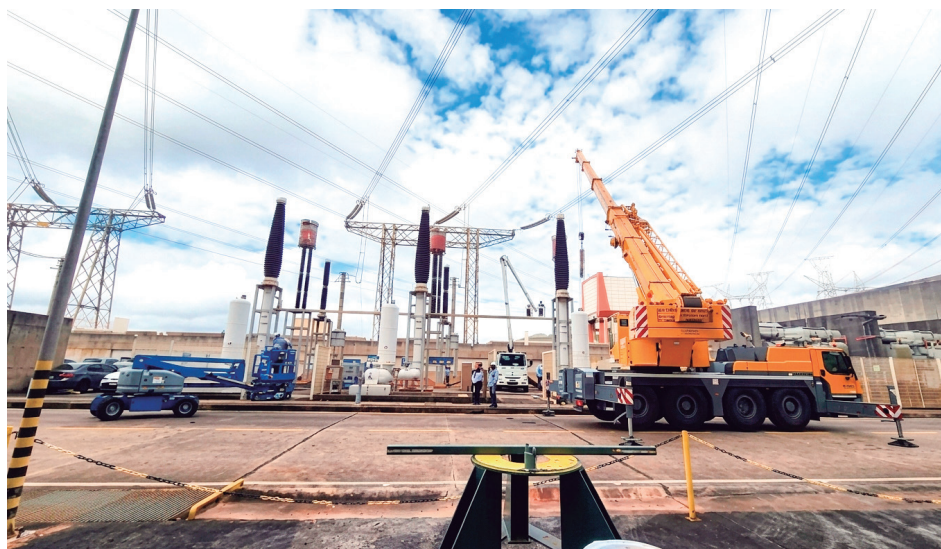
Retirada e instalação de novos equipamentos
