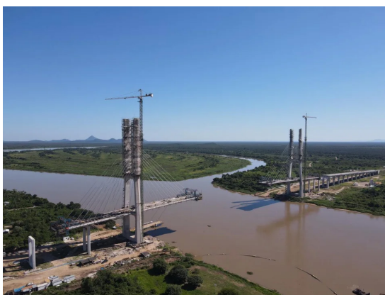
Obras na Ponte Internacional Bioceânica
