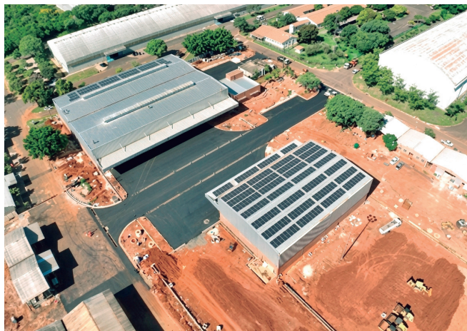
Vista aérea da construção dos almoxarifados da margem brasileira
