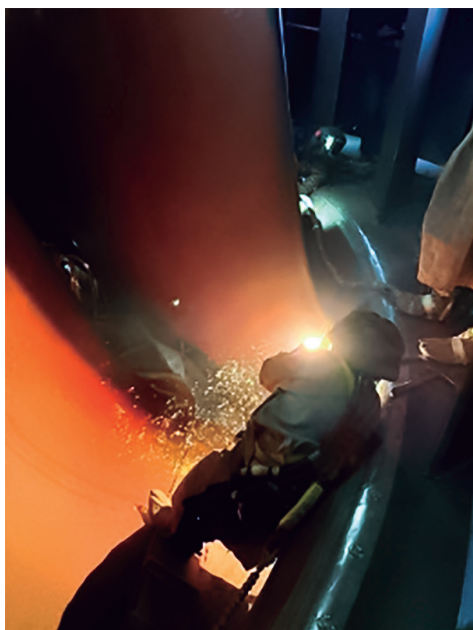
Reparo de cavitação das unidades geradoras
