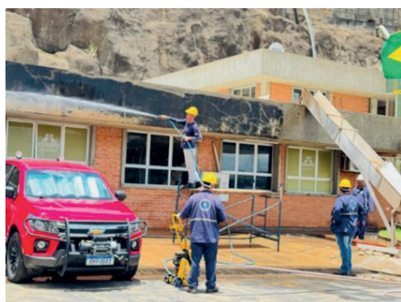
Edifício do Corpo de Bombeiros de ITAIPU
