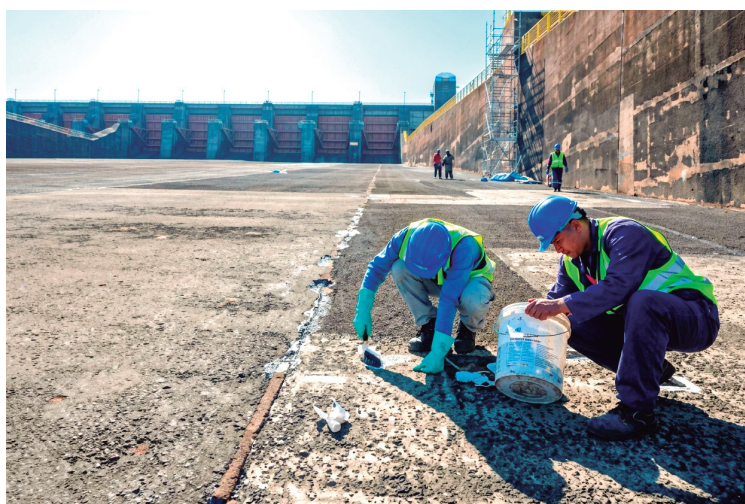
Trabalhos de recuperação do vertedouro
