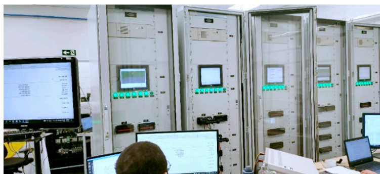
Painéis do Sistema de Oscilografia
