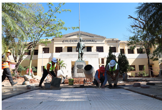
Obras no CNC
