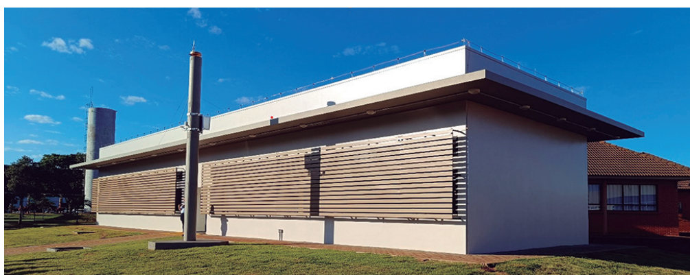
Edificação com laboratórios, salas de aula, e pilar de monitoramento geodésico construídos com recursos do convênio
