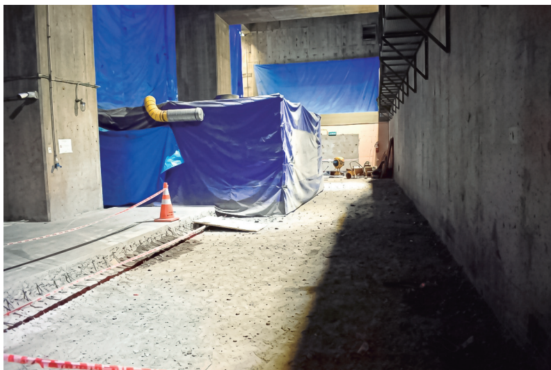
Espaço para instalação futura do SFC – demolição do piso
