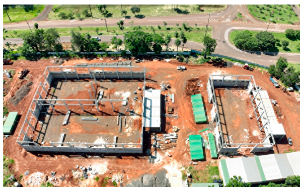
Vista aérea da construção dos almoxarifados da margem paraguaia
