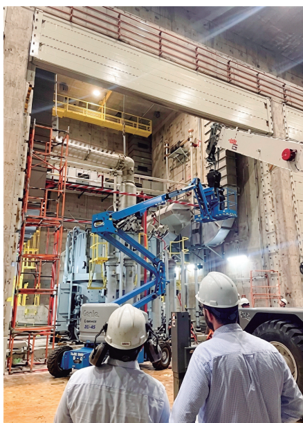
Retirada do transformador para início dos reparos
