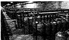
Conjunto de Baterias Principais e Reservas CO<sub>2</sub> e Válvulas de Descarga Rápida e Lenta - Sistema Antigo
