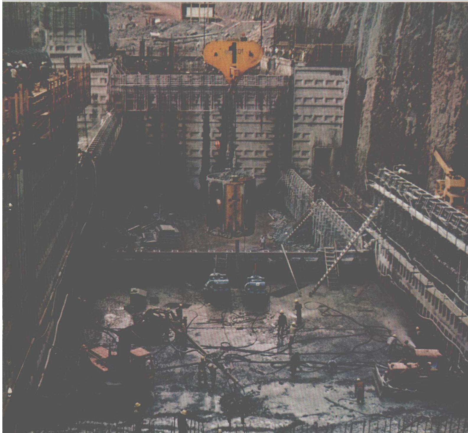
Visão de uma das fases da operação de lançamento de concreto na estrutura do desvio.
