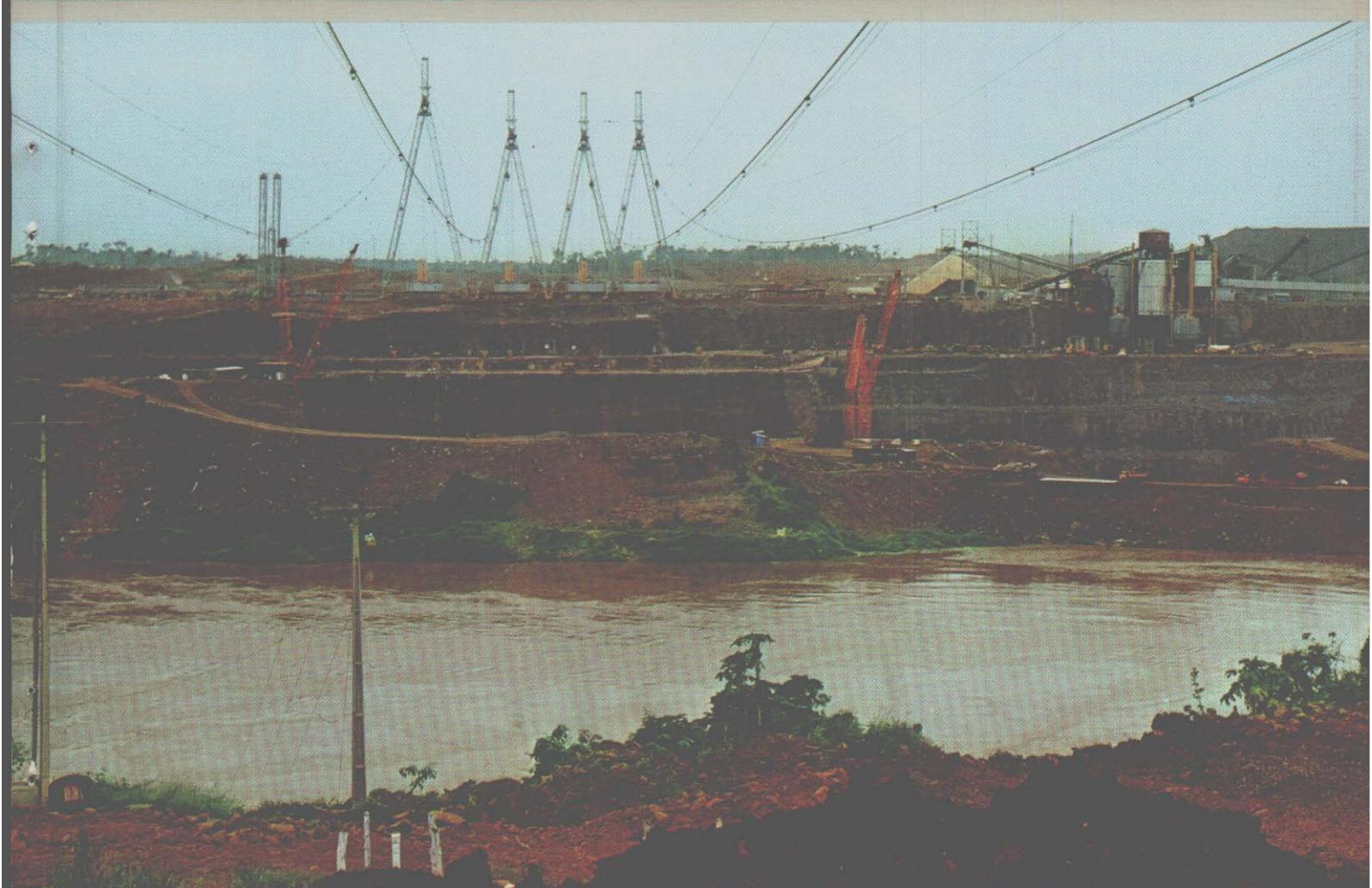
Acima: Um aspecto da Central de Britagem e de parte da Central de Refrigeração e dos Silos, em operação na margem esquerda.
