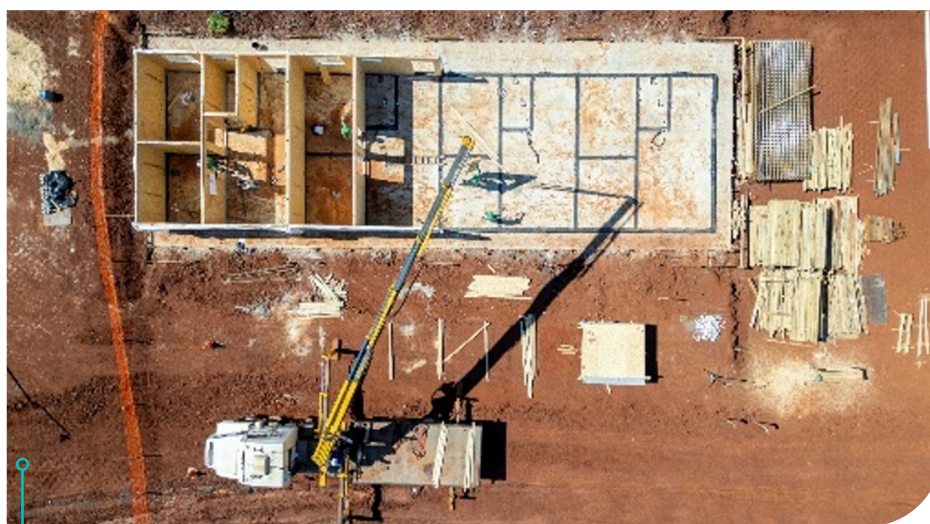
Projeto Moradias – Canteiro de Obra Lote 01
