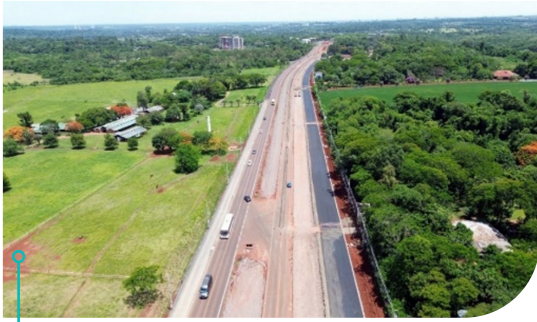
Duplicação da Rodovia das Cataratas – Marginais em execução
