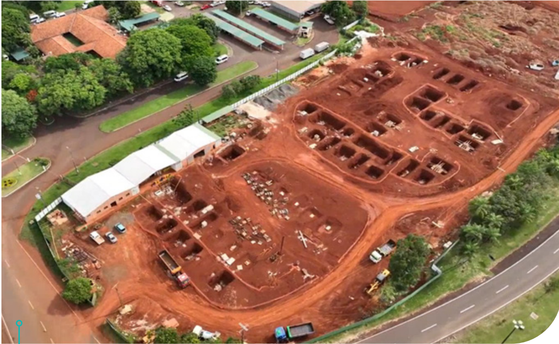
Vista aérea da construção do almonarifado da margem paraguaiã
