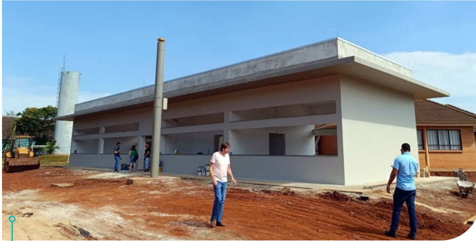
Pilar geodésico, com a estação GNSS instalada e operando, e bloco de laboratórios do Convênio NORTE em fase de instalação de esquadrias e acabamentos
