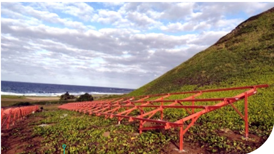
Sistema solar em montagem na ilha. Foto: Elias Pelozato, Itaipu Parquetec
