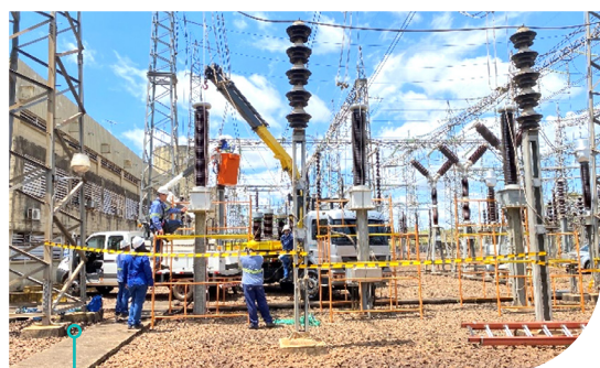
Substituição de equipamentos na SEMD transformador TA-02
