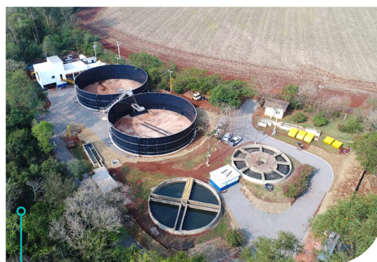
Estação de coleta e tratamento de esgoto de Itaipulândia
