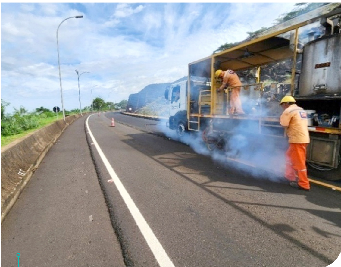
Repavimentação asfáltica
