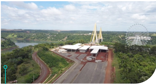
Construção da Aduana BR/PY e a Ponte da Integração
