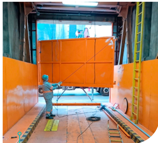
Pintura e modernização da estrutura e equipamentos
