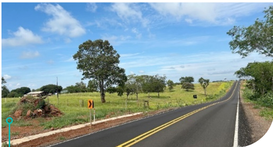
Reforma da Estrada Rural São Roque/Ramilândia – Primeiros 6 km entregues
