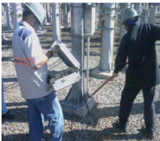
Medição Sistema de Aterramento Setor de 500kV.
