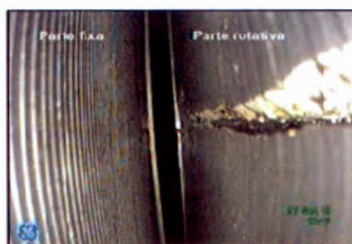
Visão ampliada da trinca no anel no sentido longitudinal
