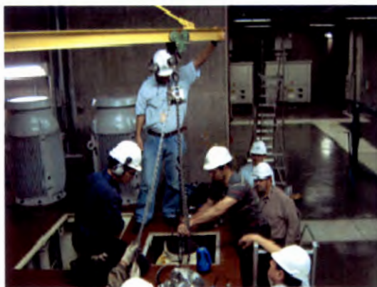
Desmontagem para reparo da válvula distribuidora da U18A, realizado pela SM.DT, sob a supervisão e responsabilidade do CEITAIPU/Alstom.
