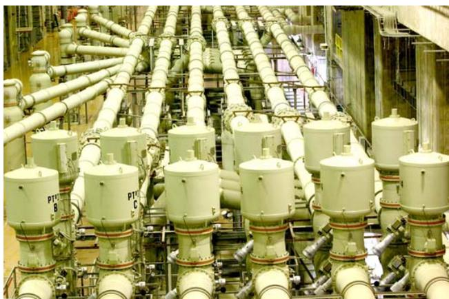
Uma vez comprovada a eficiência dos equipamentos, a ITAIPU, em abril de 2005, adquiriu do mesmo fornecedor – a *Diagnostic Monitoring System Ltd. (DMS)*, o referido sistema para a totalidade dos bays da Subestação Isolada a Gás. O sistema permite maior flexibilidade nas manutenções preventivas, redução dos custos e aumento da confiabilidade operativa da GIS.
