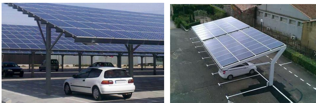
Figura 1. Imagem ilustrativa de painéis em estacionamento
