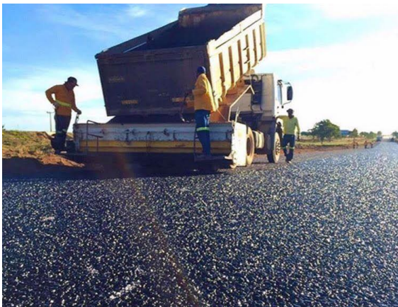
Distribuidor de agregados rebocável
